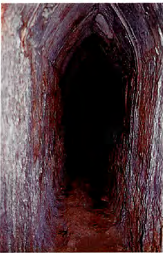
Bild 16 Ein Blick in den unterirdischen Aquädukt Foto: H. Kienast, Athen
